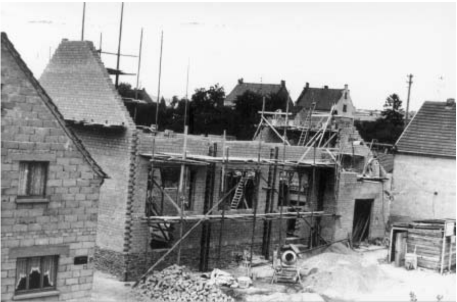
Abb. 9: Evangelische Kirche im Rohbau; links Haus Urmersbach, rechts Haus Scholl; Foto: evangelische Kirchengemeinde
