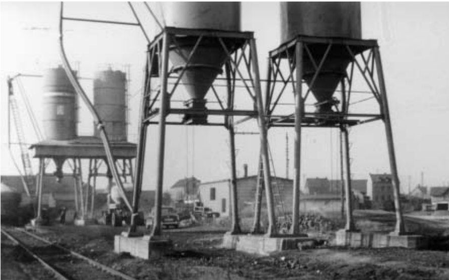
Abb. 6: Siloanlage am Plaidter Bahnhof
