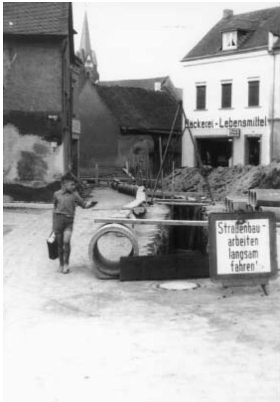
Abb. 13: Neue Kanalisation „Auf der Pütz“
