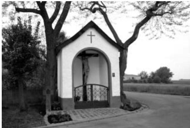
Abb. 32: Jetzt wieder ansehnlich: die Hochkreuzkapelle in der Alten Andernacher Straße; Foto: Wolfgang Horch
