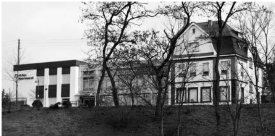
Abb. 17: Das Gebäude der Plaidter Raiffeisen-Bank vor der „Renovierung“; die alte Villa rechts wurde für dieses Projekt abgerissen; Foto: Frank Neupert.
