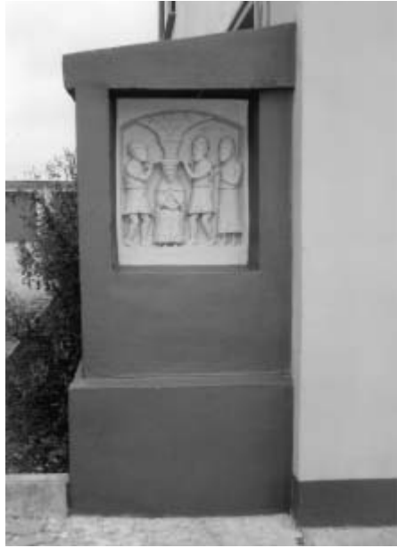
Abb. 3: ... und nach der Restaurierung
