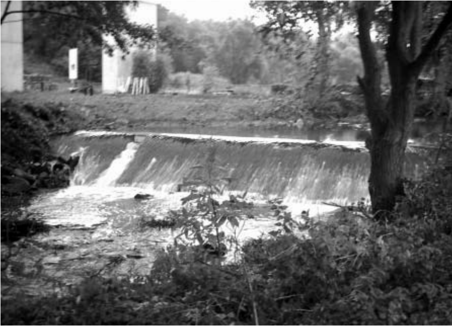
Abb. 1: Die Wehranlage „Gottschalksmühle“ vor den Umbaumaßnahmen; alle Fotos in diesem Beitrag, sofern nicht anders vermerkt, aus dem Archiv des Plaidter Geschichtsvereins
