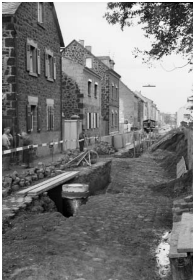
Abb. 3: Die Miesenheimer Straße wird kanalisiert und das Pflaster durch eine Teerdecke ersetzt.
