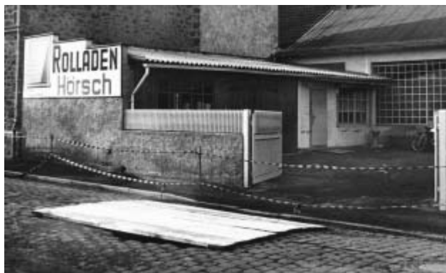
Abb. 24: Der abgedeckte Einbruch vor der Einfahrt zur Firma „Rolladen Hörsch“
