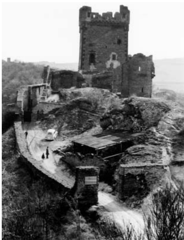
Abb. 39 und 40: Renovierungsarbeiten an der Ruine der Burg Wernerseck
