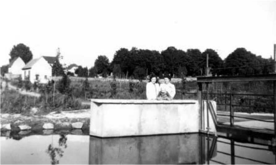
Abb. 5: Der Sandfang des Krufter Bachs im Sonnenland, der regelmäßig ausgebaggert werden muss, ist Thema im Gemeinderat.
