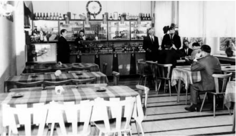
Abb. 22: Blick in den Schankraum der Bahnhofsgaststätte
