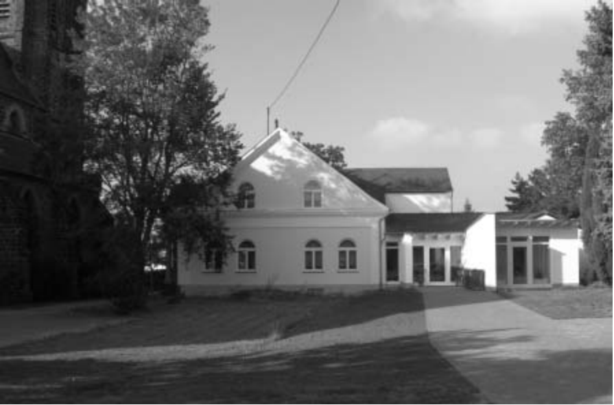
Abb. 12: Zum Teil abgerissen, zum Teil neugebaut: das „Klösterchen“; Foto: Otmar Lohner
